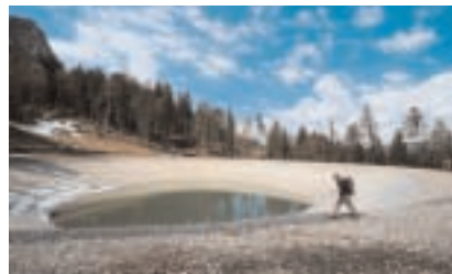
Direkt neben der Kandahar-Abfahrt wurde 2008 ein weiterer Speicherteich errichtet
